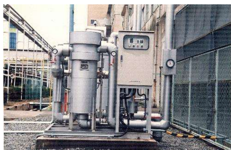
鍋爐排水過濾裝置 孔徑: 0.005 \mu m ~ 0.1 \mu m
